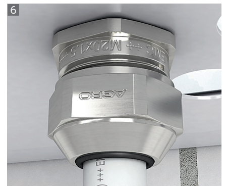
6 キャップを締付けて完了。
