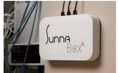
取付けをする
