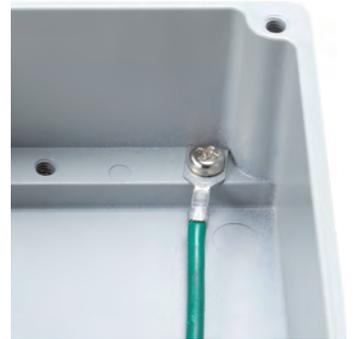
■ビスの裏側に突起が出ておりますので当社製品のアルマイト処理やアルミ塗装材の表面のアルマイト層や塗膜層を削り、材料の素地と接触させます。様々な製品にご利用いただけます。
