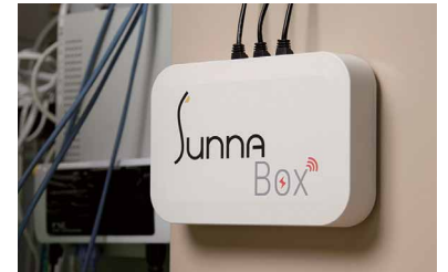
取付けをする
